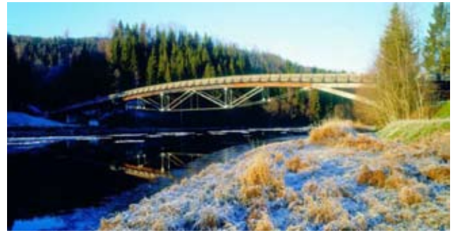
4 pav. Kjærra pėsčiųjų tiltas per Numedalslågen upę Norvegijoje [9]
