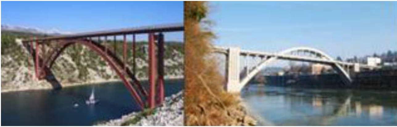
1 pav. Arkinis tiltas su paklotu virš arkos ir tiltas su paklotu arkos viduryje
