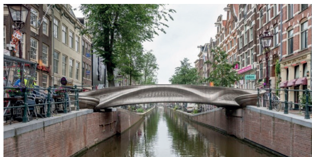
19 pav. Tiltas Amsterdame išlietas 3D spausdintuvu Šaltinis: www.mx3d.com
