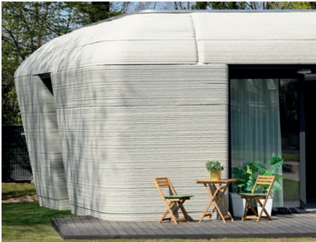
23 pav. Adityvios gamybos būdu Olandijoje išlietas namas Šaltinis: www.compositesworld.com
