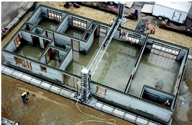
20 pav. SQ4D statybų procesas Šaltinis: www.3Dprintingindustry.com
